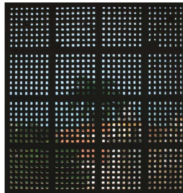
VISTA INTERNA DA CAIXA D'ÁGUA DE OLINDA, PERNAMBUCO
